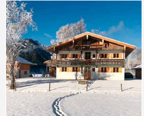
Das Sollacher-Anwesen nach der Renovierung
