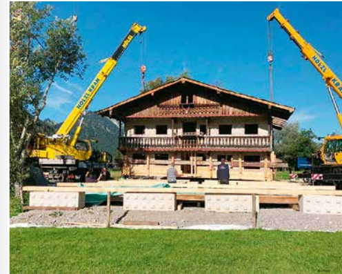
Versetzung des Hauses mit zwei Autokränen
