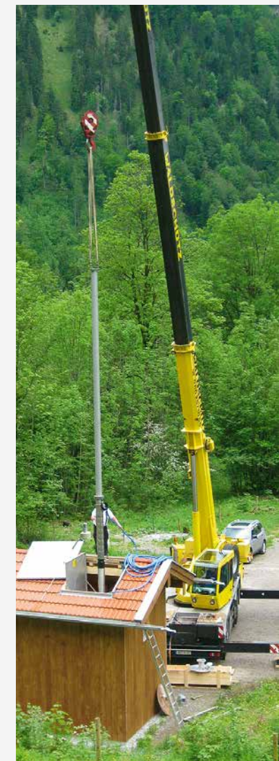
Einbau der Brunnenpumpe am Brunnenhaus Melkstatt
