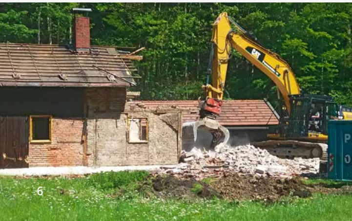
Abbrucharbeiten am „Schwersen Gatter“
