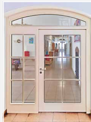
Brandschutz – Die neue Glastür in der Aula als rauchdichter Abschluss zum Treppenhaus
