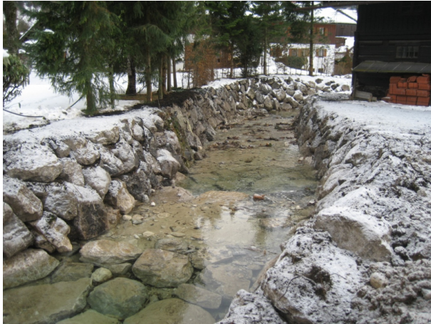
Abbildung 7: Neue Ufersicherung bei Flur-Nr. 54/27
