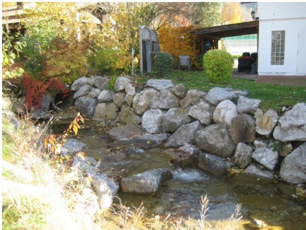
Abbildung 9: Neue Ufersicherung bei Flur-Nr. 49/8
