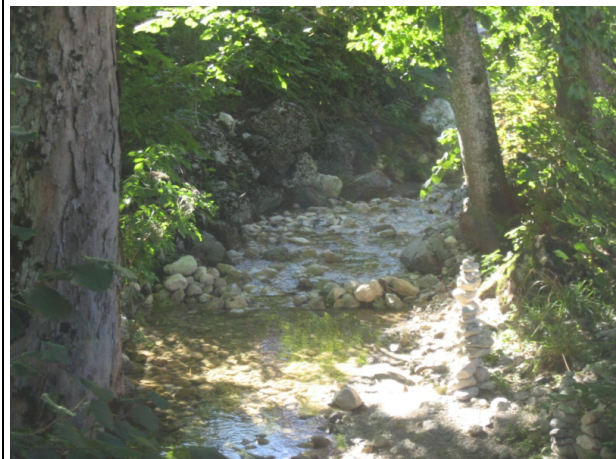
Abbildung 6: Ufersicherung mit Wasserbausteinen
