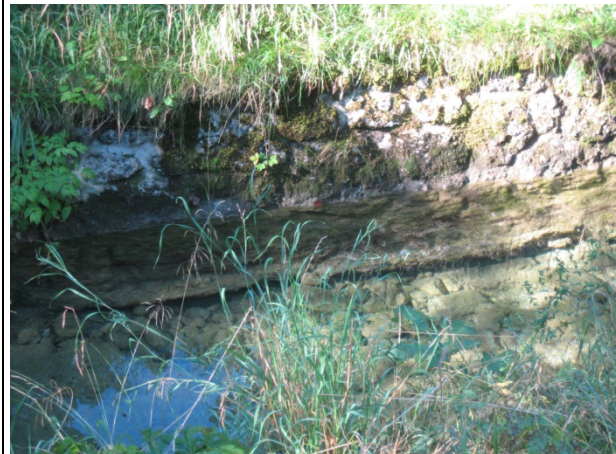
Abbildung 4: Unterspülung Ufermauer
