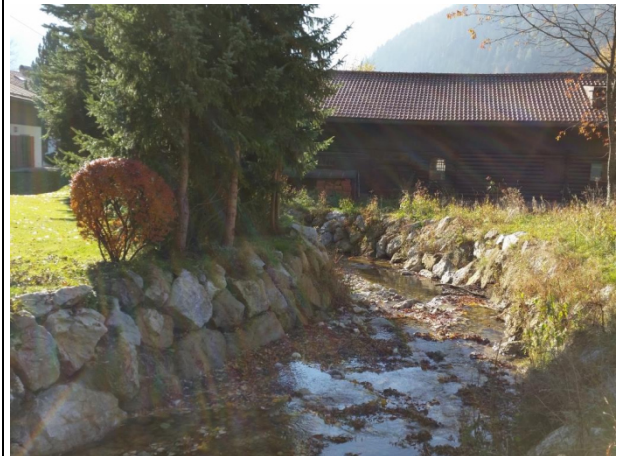
Abbildung 10: Neue Ufersicherung bei Flur-Nr. 54/28 (linkes Ufer) und 49/6 (rechtes Ufer)
