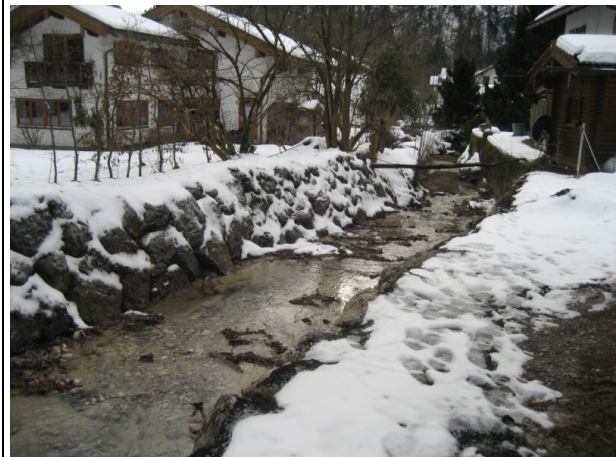
Abbildung 8: Neue Ufersicherung bei Flur-Nr. 54/31 (linkes Ufer) und 49/6 (rechtes Ufer)
