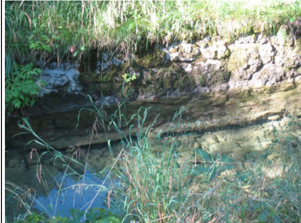
Abbildung 4: Unterspülung Ufermauer
