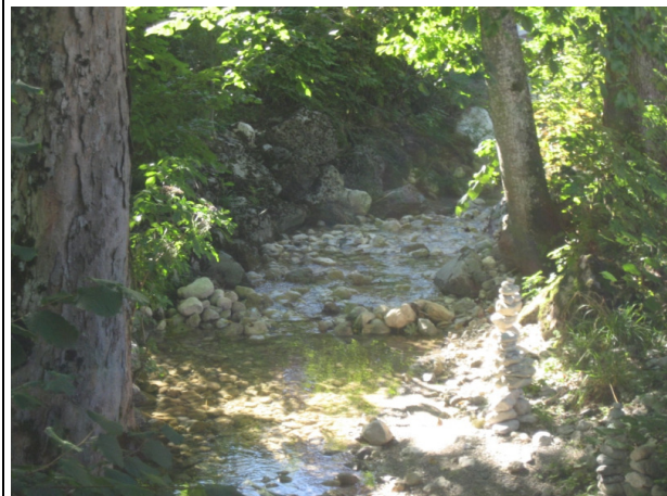
Abbildung 6: Ufersicherung mit Wasserbausteinen
