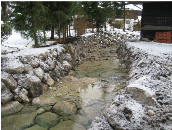
Abbildung 7: Neue Ufersicherung bei Flur-Nr. 54/27
